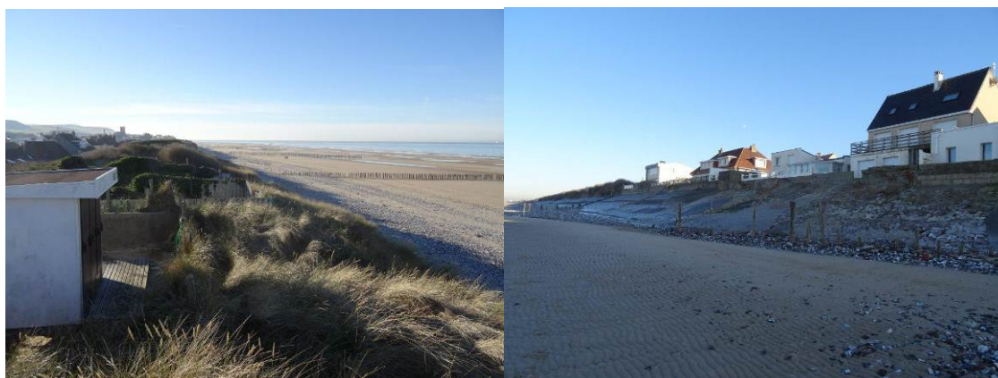
Figure 48 : Habitations et chalet, en surplomb de la dune, protégés par la digue de Sangatte (Egis, Hiver 2013-2014)
