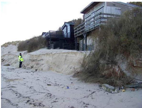
Figure 45 : Chalets perchés sur la dune d'Amont à l'extrémité nord-ouest de Wissant (DDTM 62, 2013)
