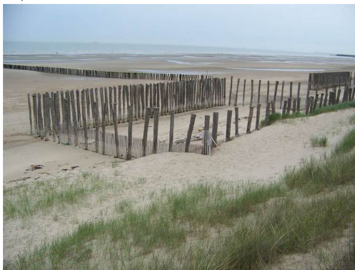
Figure 57 : Casiers et épis au Platier d'Oye (DDTM 62, 2013)
