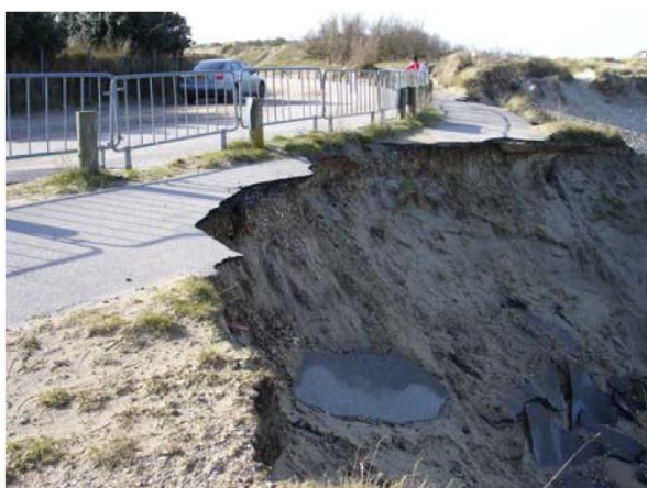
Figure 33 : Erosion de la route en corniche directement à l'est de la Pointe du Touquet (Battiau-Queney, 2008)
