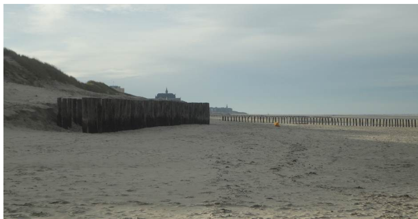
Figure 30 : Épis et brise-lames expérimentaux au Nord de Berck (Egis, Novembre 2013)
