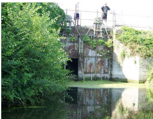
Figure 23 : Porte du Fliers à Waben (DDTM 62, 2013)
