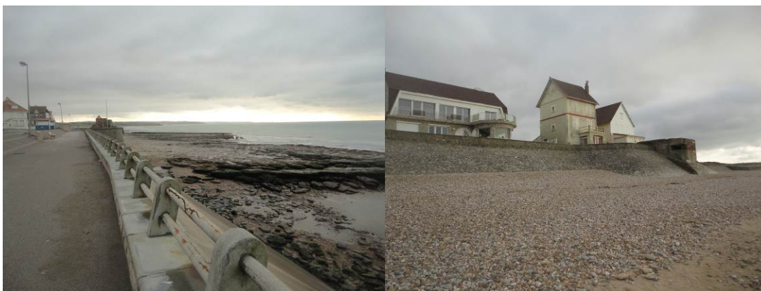
Figure 39 : Platier rocheux devant la digue d'Ambleteuse (gauche) et accumulation de galets en haut de plage à Audresselles (droite) (Egis, Decembre, 2013)
