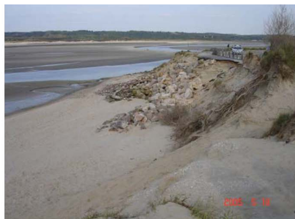
Figure 33 : Erosion de la route en corniche directement à l'est de la Pointe du Touquet (Battiau-Queney, 2008)
