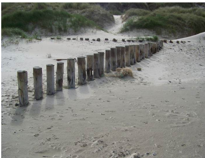
Figure 37 : Epi expérimentaux en haut de plage à Sainte-Cécile-Plage (DDTM 62, 2013)
