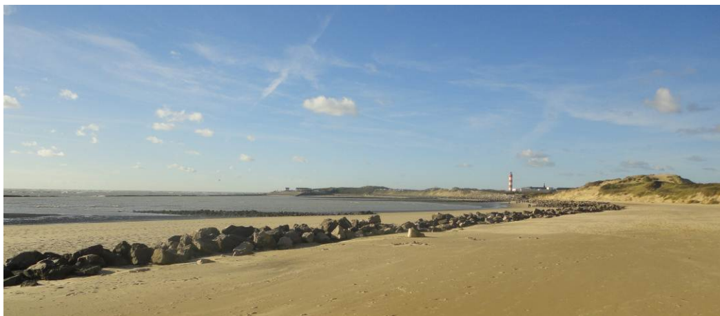
Figure 26 : Anse des Sternes et Pointe du Haut-Banc au fond – cette photo illustre le recul du cordon dunaire derrière le cordon d’enrochements (Egis, Novembre 2013)
